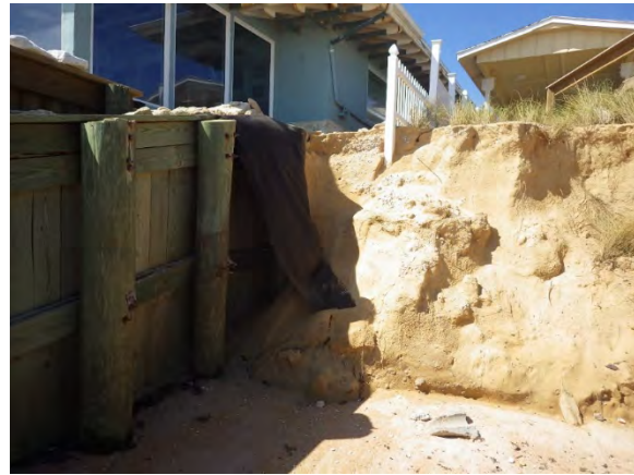
b) North wing wall scour of the timber sheet pile wall (Latitude 29°32'28.35"N / Longitude 81°9'27.15"W).
