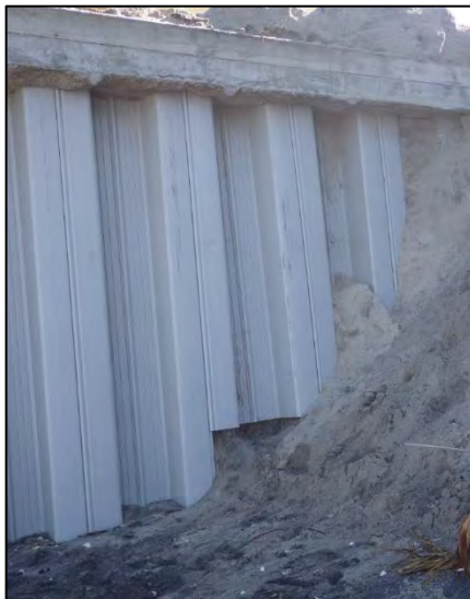
a) Exposed bottom of sheet pile wall (Latitude 29°56'58.35"N / Longitude 81°18'12.10"W).
