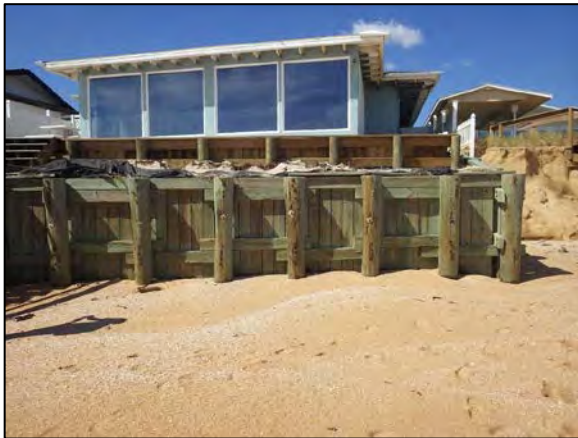
a) Two-tiered timber sheet pile structure (Latitude 29°32'28.35"N / Longitude 81°9'27.15"W).
