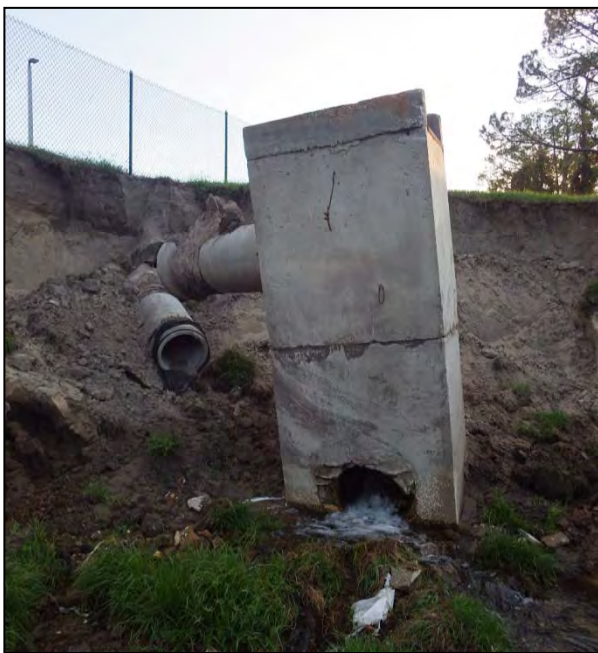
Figure 45. Damaged drainage structure 3 (Latitude 28°41'9.08"N / Longitude 81°30'22.39"W).
